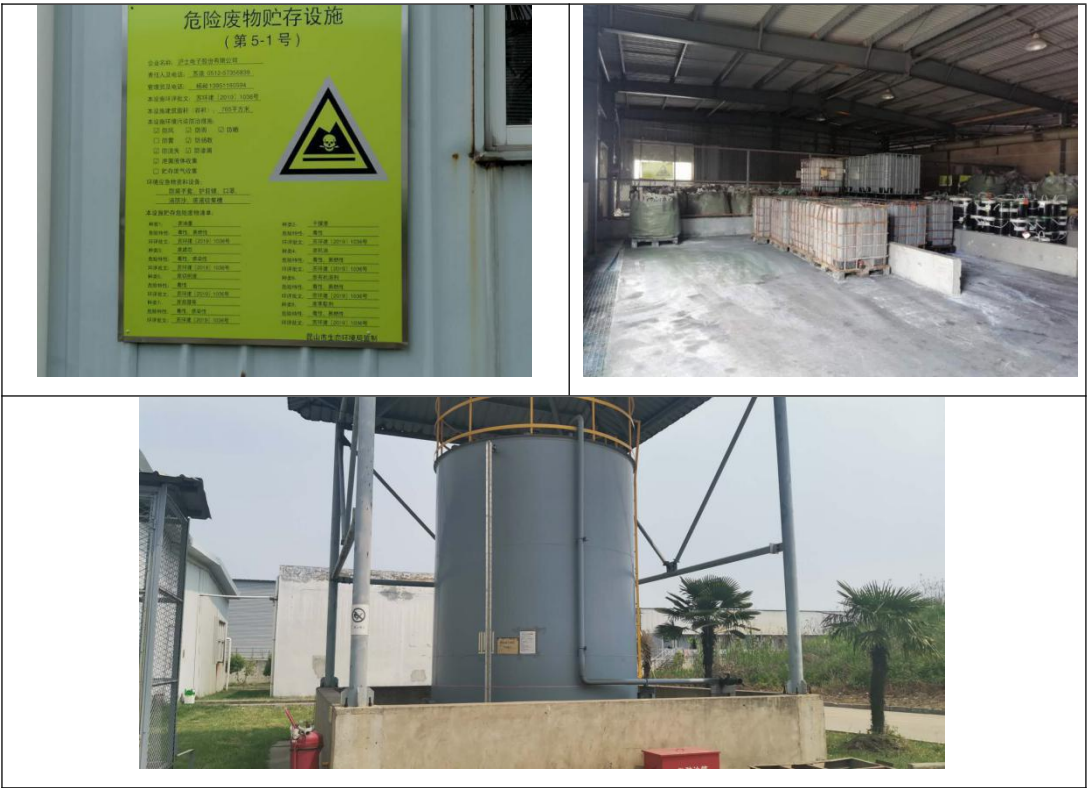
图 5-4 危废仓库 1 号和柴油储罐图
